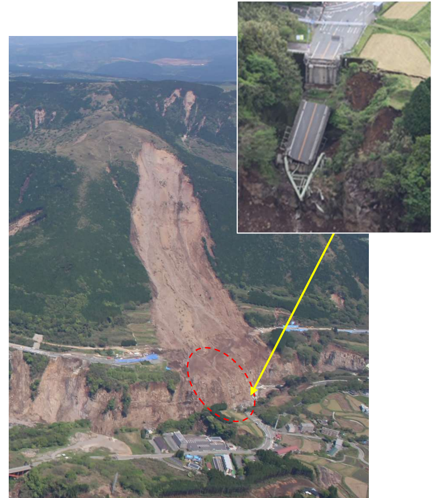
阿蘇大橋(2016年熊本地震で発生した斜面崩壊の影響による崩壊)
