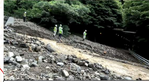
敦賀TN福井側坑口
