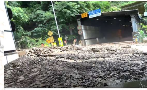
大谷第2TN第3TNの間
