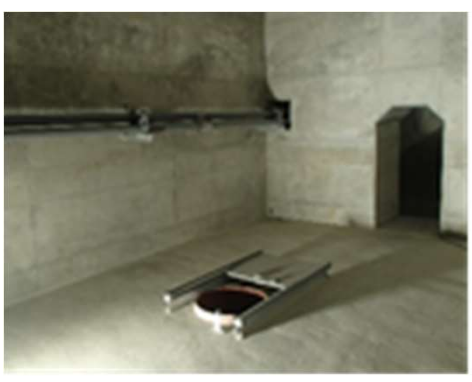
中空橋脚の柱頭部に点検孔を設置
